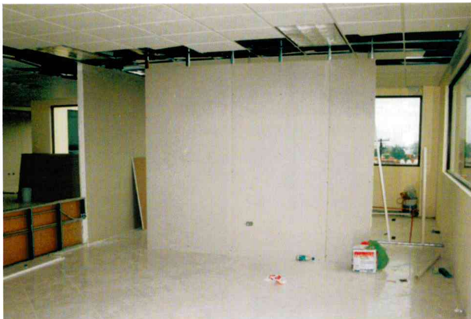
Remodelación de áreas de trabajo
