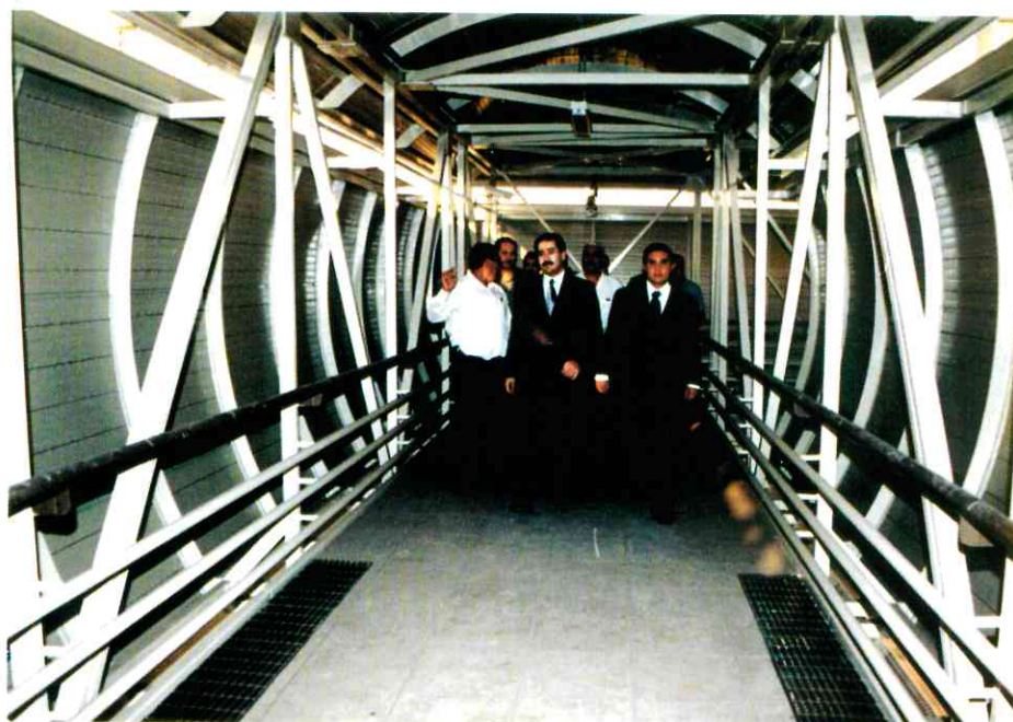
Puente peatonal que conecta la penitenciaría con el Palacio de Justicia
