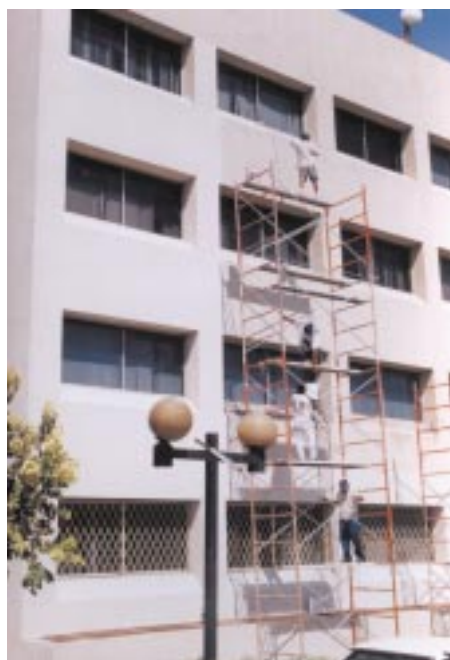
Trabajos de remodelación en Palacio de Justicia de Monterrey
